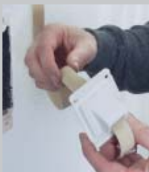
6. Gurtband in ESM- Gurtführung einziehen
