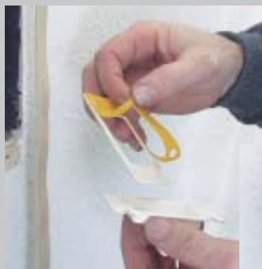
5. Schutzfolie lösen und Zellkautschuk-Dichtrahmen aufkleben
