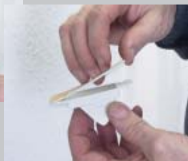
5. Schutzfolie lösen und Zellkautschuk-Dichtrahmen aufkleben
