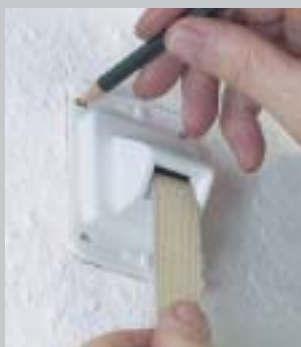
7. Schraubposition anzeichnen
